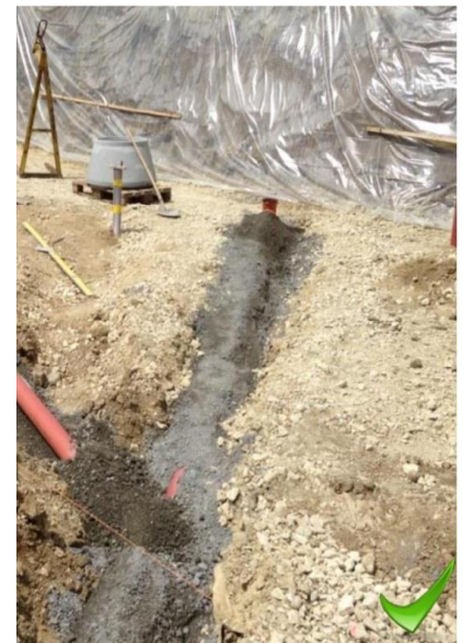
En cours de bétonnage
