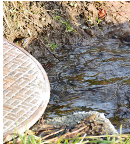
Avant les travaux, l'eau refoulait et s'écoulait dans le terrain.
