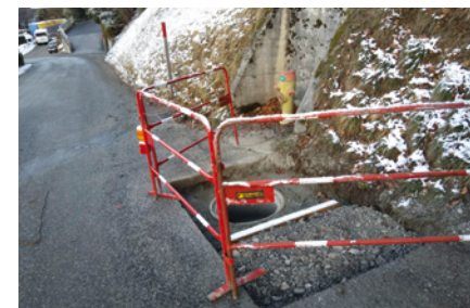
Pour accéder à la totalité de la conduite avec une caméra, une nouvelle chambre a été créée à mi-chemin.
